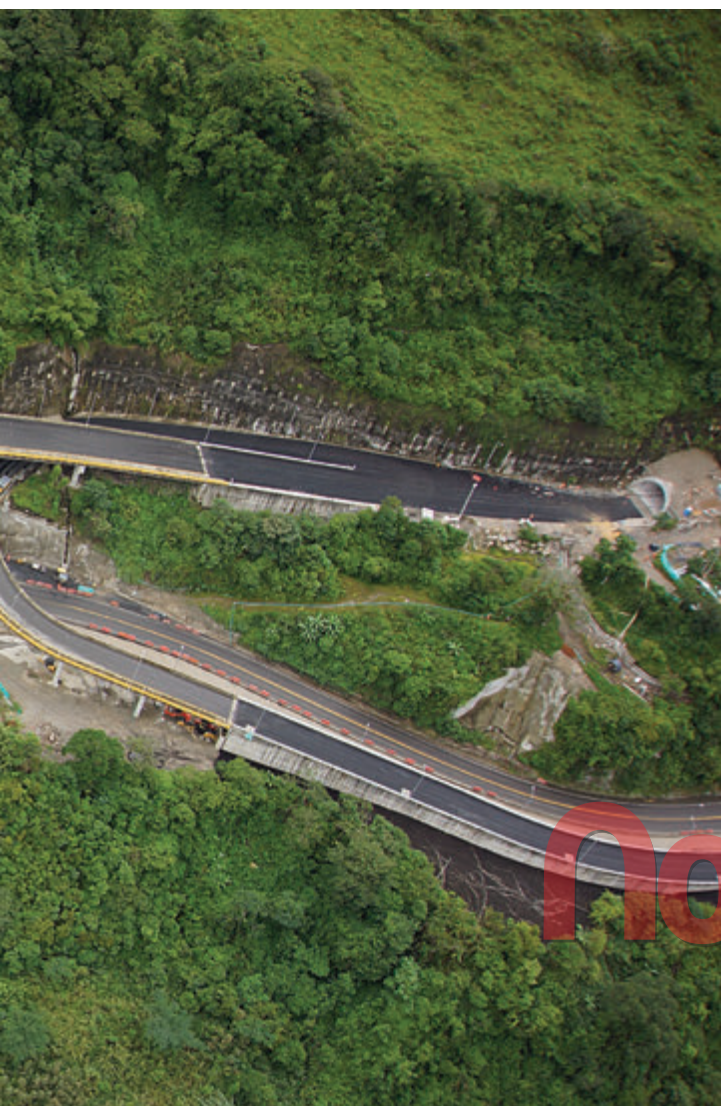
↑ Combinación de túneles y viaductos en la vía Bogotá Villavicencio. ARCHIVO COVIANDES
