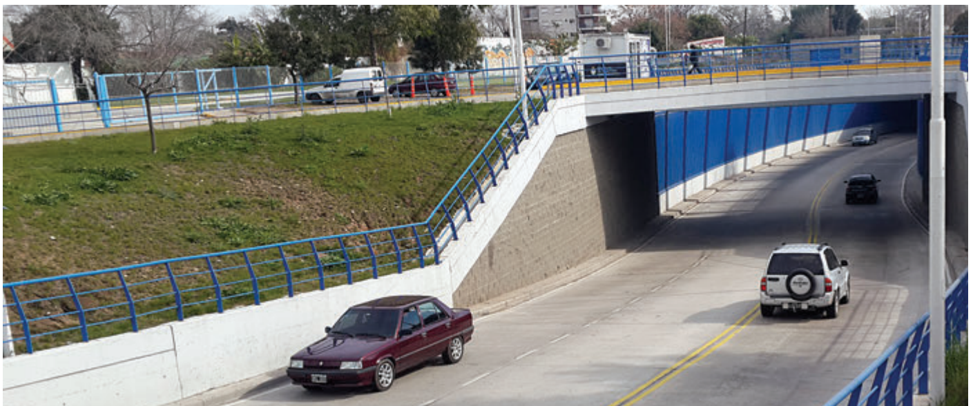
↑ Paso bajo nivel construido por debajo de las líneas ferroviarias, cuya impermeabilización se realizó con membranas flexibles de PVC. CORTESIA SIKA COLOMBIA S.A.
