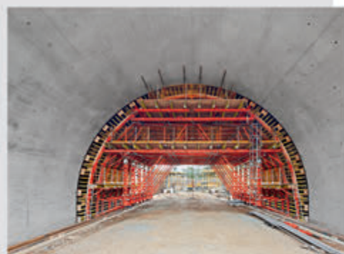
Túnel RN88 Francia
