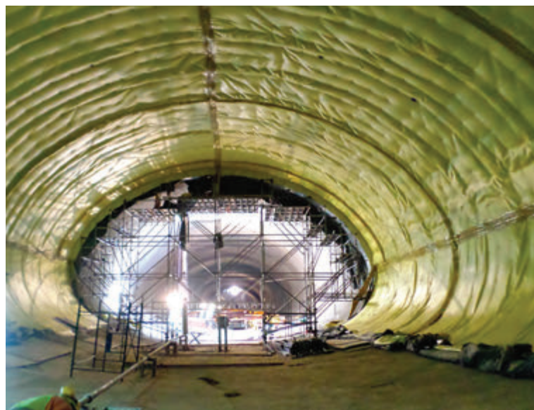
↑ Impermeabilización de la bóveda — sistema de membrana de PVC-P de 2mm de espesor en el Metro de Buenos Aires. CORTESÍA SIKA COLOMBIA S.A.
