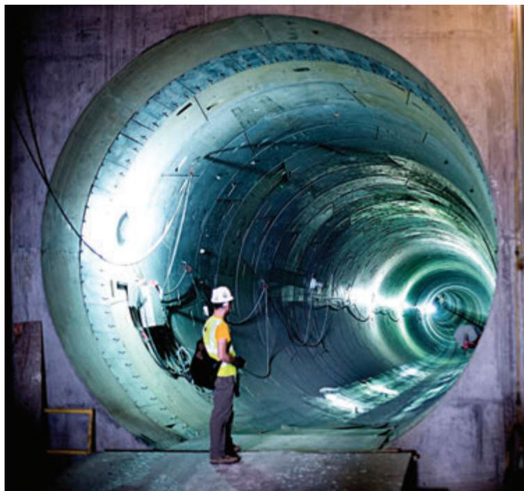
↑ Para el túnel del Central Subway de San Francisco se formuló un conjunto híbrido de concreto con fibras de acero (SFRC) con un armado de barras lo cual resultó mucho más liviano y con buenas propiedades de resistencia.
