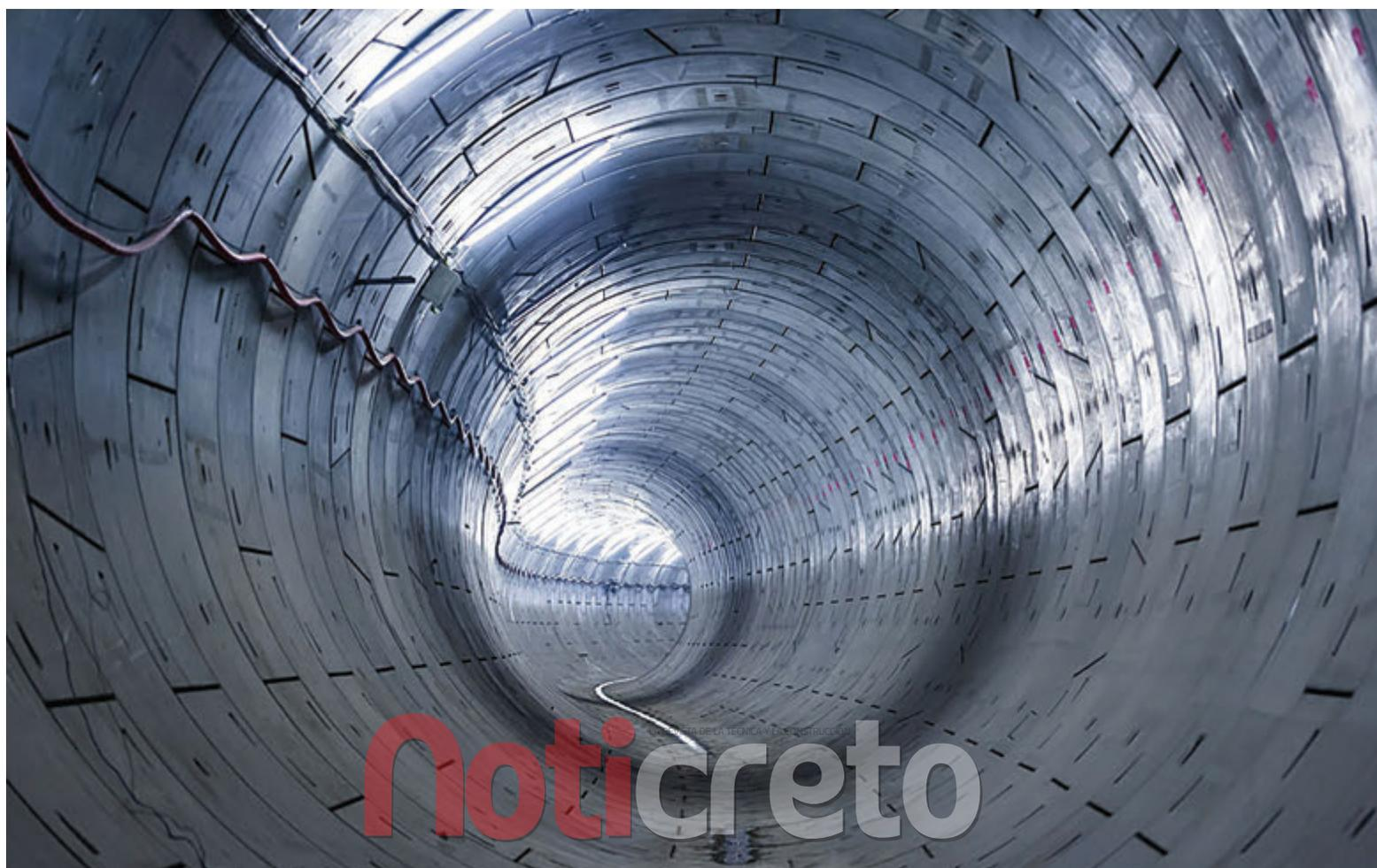
↑ Los segmentos prefabricados de concreto para revestimiento de túneles han tenido importantes evoluciones.
