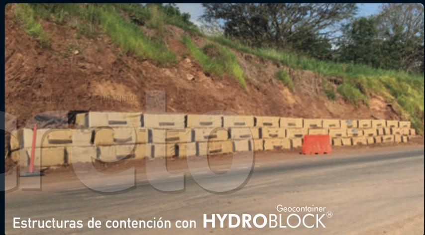
Estructuras de contención con Geocontainer **HYDROBLOCK®**
